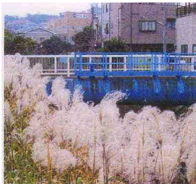
(7) 武者が谷橋瓢豊田橋 橋に平行して水道管 が通っている
