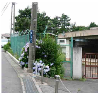
(8) 港南ずい道配水地笹下ポンプ場 港南 1-22、 港南区に別れる前 ここは南区笹下だった
